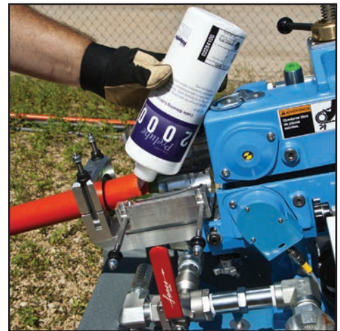
Figure 38. Pour Lube into Conduit
